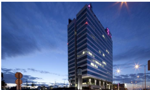
Administrativní budova Forum BC I, Bratislava, SR
