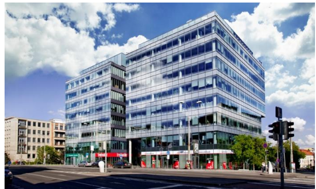
Administrativní budova Park One, Bratislava, SR
