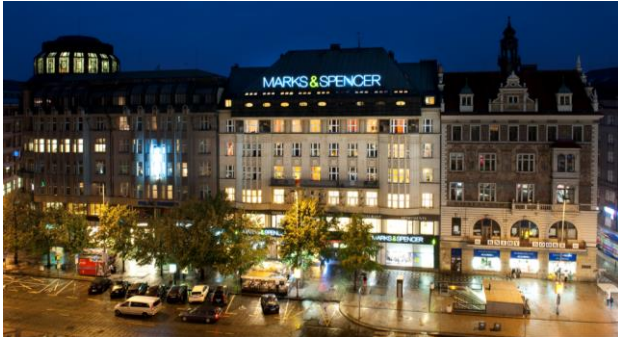
Multifunkční budova Melantrich, Praha, ČR
